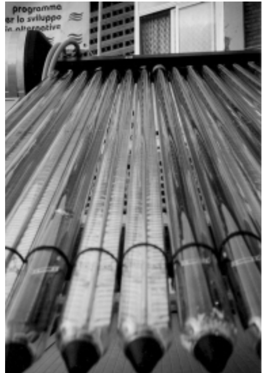
Figura 2.6 - Serie di tubi evacuati (alcuni sono girati per mostrare il tubo bicavo del fluido termovettore).
