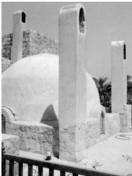
Figura 4.5 - Camini a vento ( malqaf ) su una casa egiziana. Di frequente contengono tappeti o carbonella umidi per rinfrescare ulteriormente il vento che vi entra. [2]
